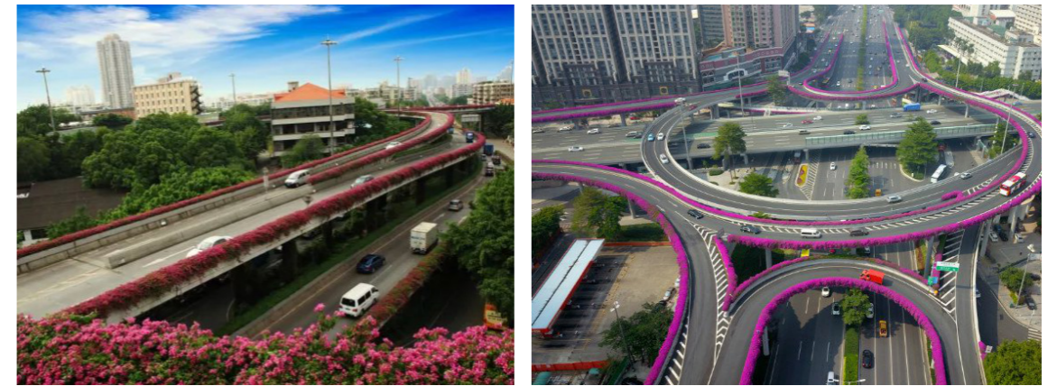
图 5.01 车行桥梁种植槽绿化
